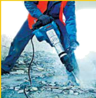
Демонтаж асфальта, бетона
