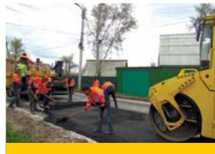
Асфальтирование дороги, г. Ростов-на-Дону, ул. Тракторная, 2010 г
