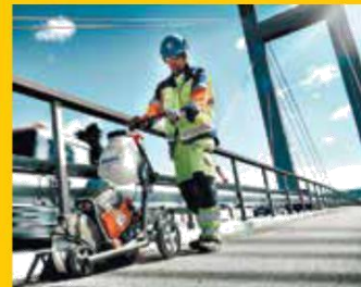
Алмазная резка асфальта
