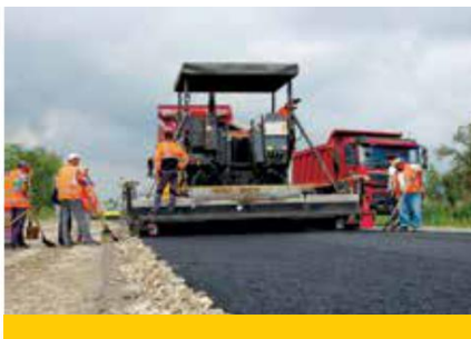
Строительство дороги, п. Щепкино, Ростовская область, ул. Сливовая, 2013 г
