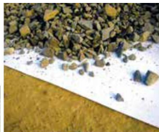
Армирование геотекстилем
