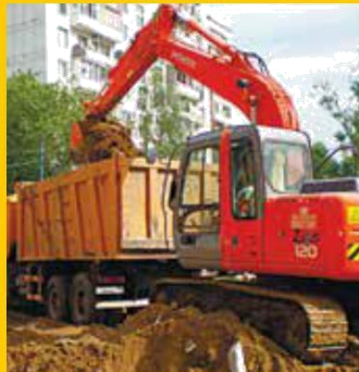
Вывоз грунта и строительного мусора
